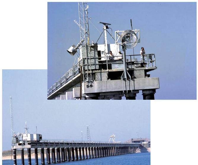
ダック沿岸にあるCERCの観測用栈橋、先端部には各種の観測用測定器
