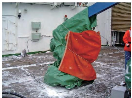
写真9 採水用クレーンの凍結防止(協力: JAMSTEC)
